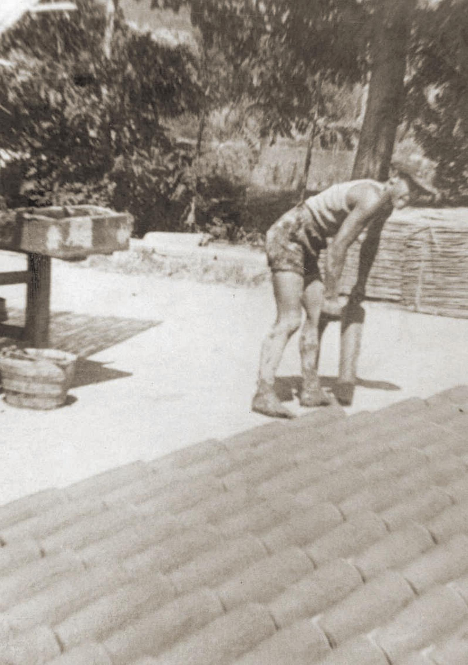
chio che veniva appiattita e rasata con una specie di corto mattarello, *la canèlà*, in modo da realizzare una lamina a forma di trapezio dello spessore di un cm e mezzo. La presenza di sassolini, in questa fase avanzata della lavorazione, veniva mimetizzata all'interno dello spessore della lamina.
