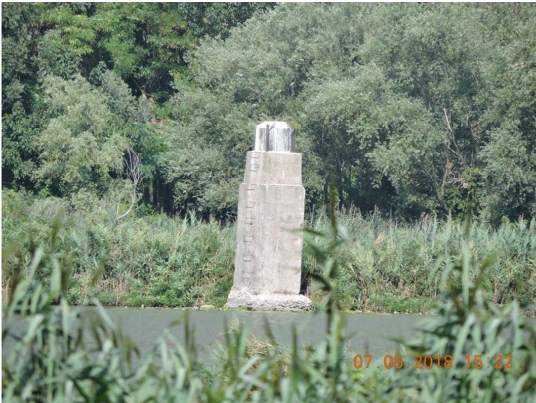
Uno dei due tralicci su cui verranno installati i nidi artificiali
