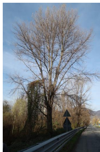
Foto 30 – tratto compreso tra la rotonda per Iseo e l'imbocco della galleria, soggetti radicati troppo vicino al sedime stradale e di cui si propone l'abbattimento
