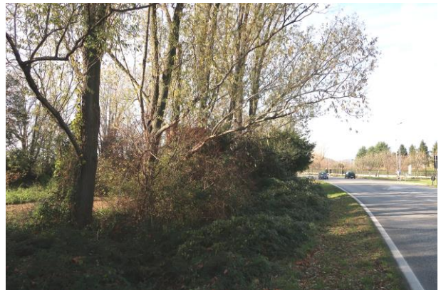
Foto 16 – Il tratto di alberate subito dopo la rotonda di Sassabanek, anche qui sono evidenti i grossi rami a sbalzo verso il sedime stradale
