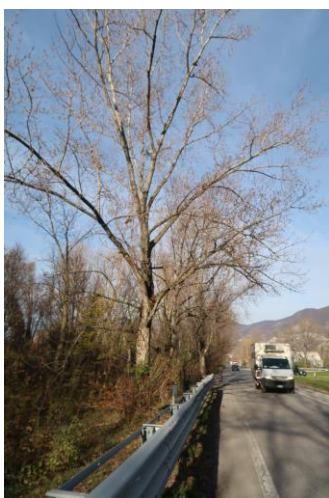
Foto 29 – tratto compreso tra la rotonda per Iseo e l'imbocco della galleria, soggetti radicati troppo vicino al sedime stradale e di cui si propone l'abbattimento
