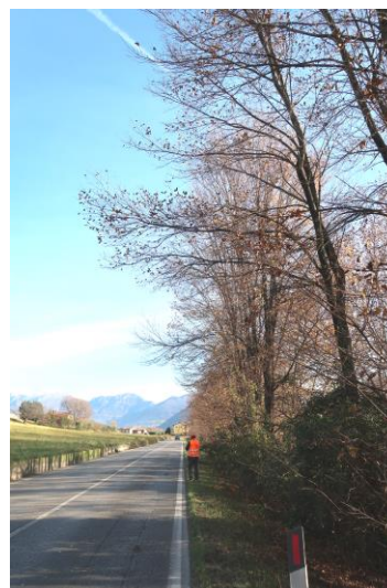
Foto 4 - Sempre in direzione Iseo, le alberate a ciglio stradale evidenti quali siano le ramature da sottoporre al taglio per evitarne la caduta sulla carreggiata.
