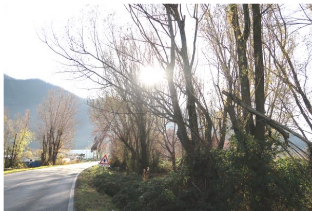
Foto 20 – secondo tratto di intervento, in direzione del campo sportivo di Iseo, dettaglio sulla disastrosa e pericolosa condizione in cui si trovano le alberature a ciglio strada con evidenti sbrancamenti e rotture
