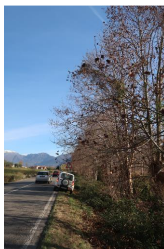
Foto 6 - I singoli soggetti in filare quasi prospicienti a Casa Colombera, anche qui sono evidenti le ramature da eliminare
