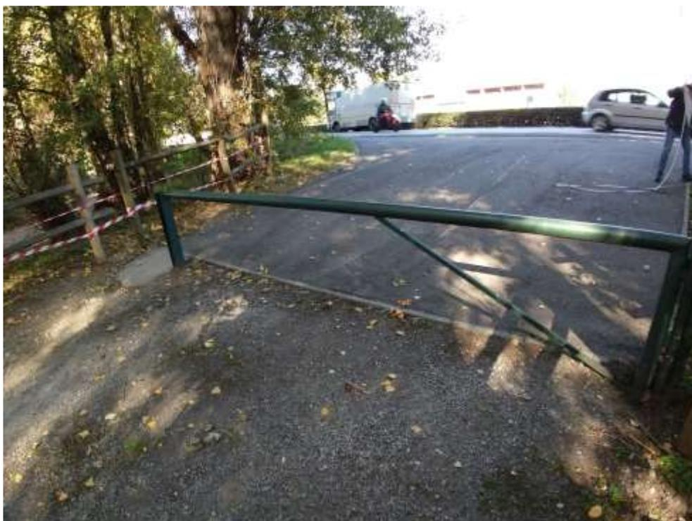
**Figura 3.2: sbarra in metallo da sostituire**
